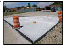
Pervious Concrete Test Pour at Euclid City Schools site
