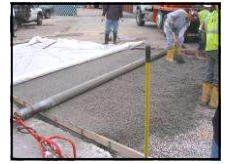
Pervious Concrete Test Pour at Euclid City Schools site
